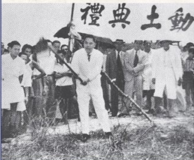
1953年7月26日中午举行动土店，陈六使挥动锄头破土，铲泥车随即铲除丛林野草，为建设南洋大学铺平道路。
