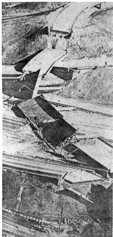
1971年美國洛杉磯地震中被破壞的公路橋樑
