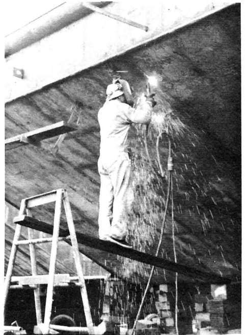
↑ 在寸步难移的木架上进行烧焊工作
